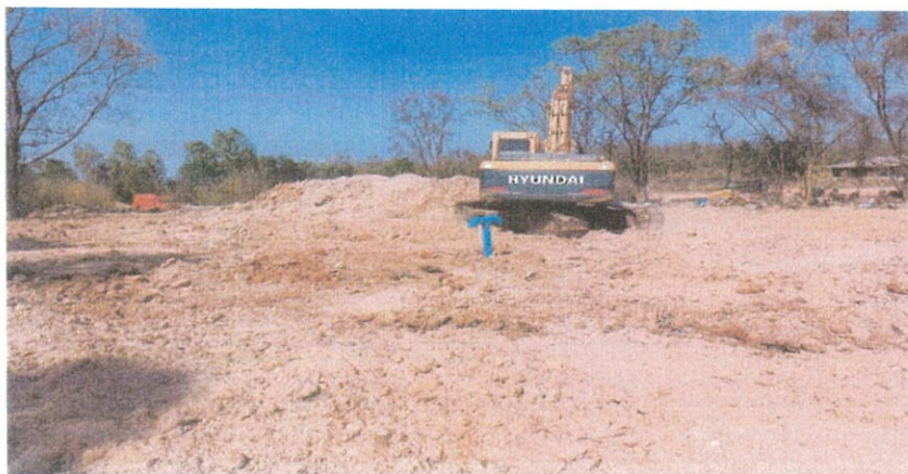
ติดตั้งท่อระบายก๊าซ เพื่อป้องกันการระเบิด ไฟไหม้ และควบคุมก๊าซที่มีกลิ่นเหม็น
